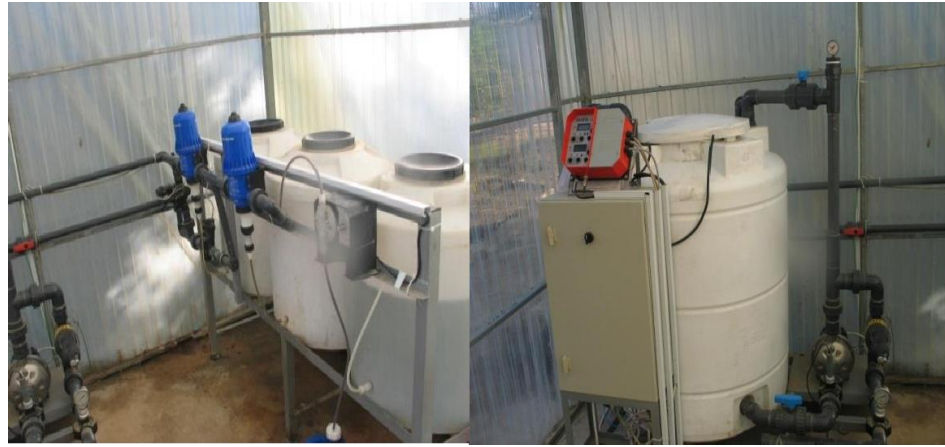
شكل (٣) نظام التسميد بالمضخات الحاقنة.
