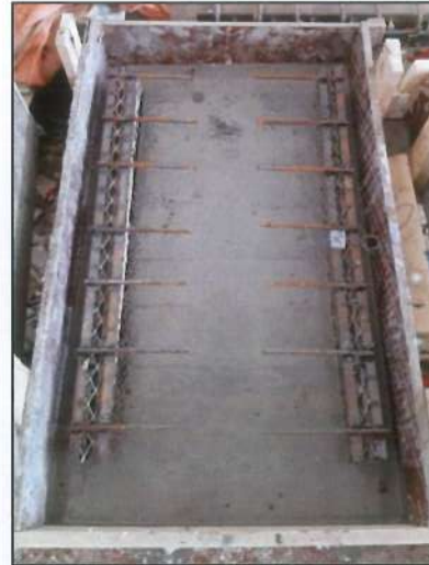
(b) Pouring down concrete wythe.
