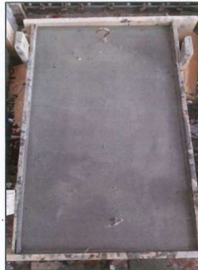
(d) Pouring top concrete wythe.
