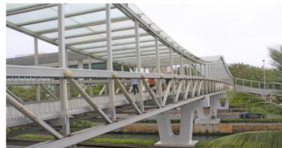
(d) Aluminium tube truss pedestrian bridge (2021)
