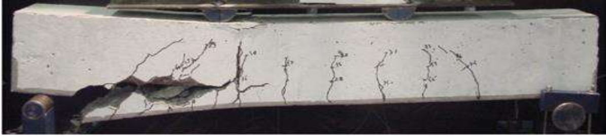
(d) experimental failure
