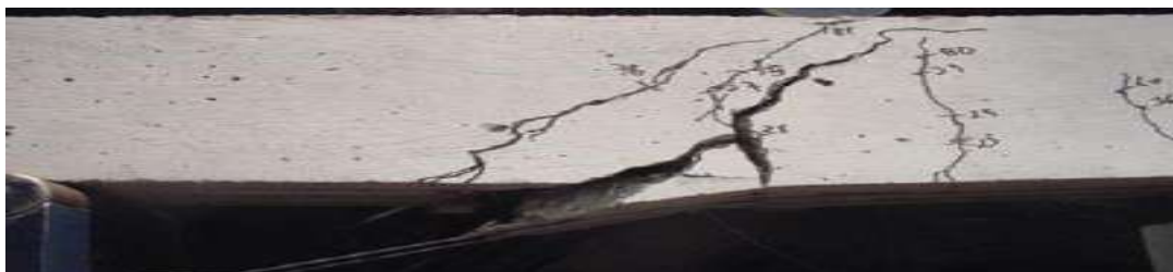
(d) experimental failure
