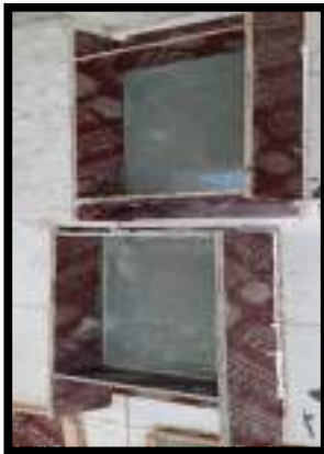
(d) Precast panels.
