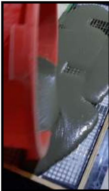
(d) Apply mortar.
