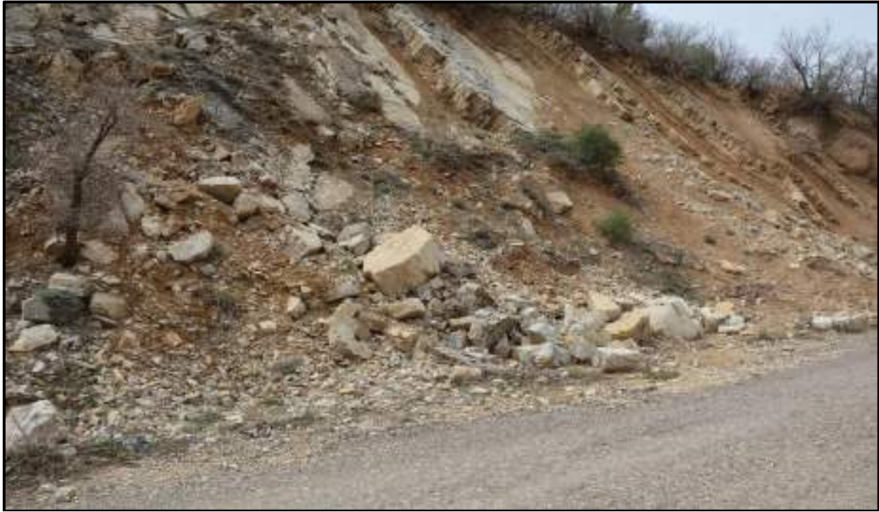
صورة (45) الانزلاق الصخري في شرق منطقة الدراسة
