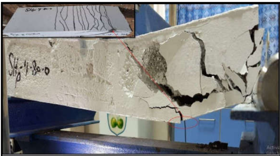
(d) Mode of failure for SHp-4-80-0 specimen.
