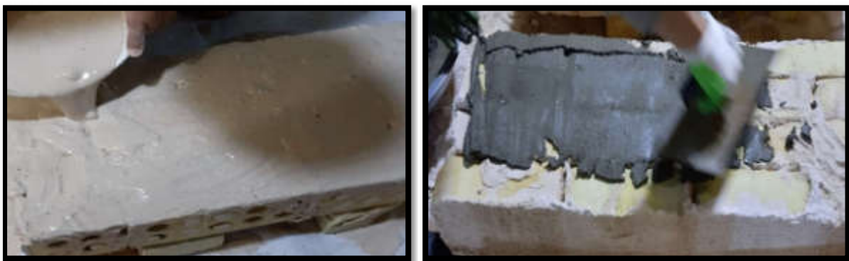
(d) Apply gypsum mortar on top face.
